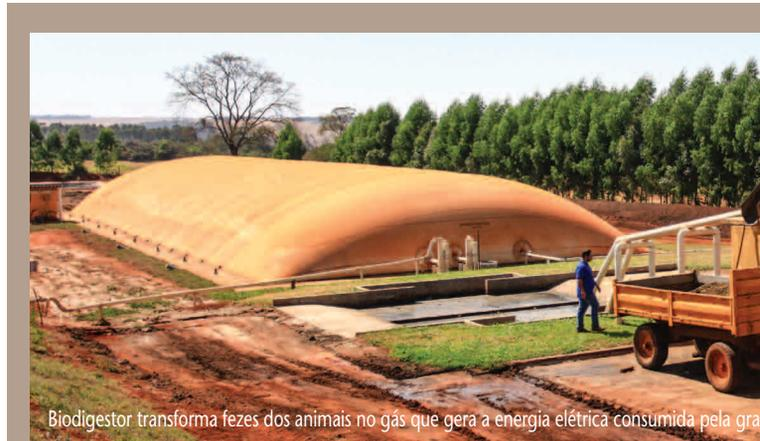
Biodigestor transforma fezes dos animais no gás que gera a energia elétrica consumida pela granja
