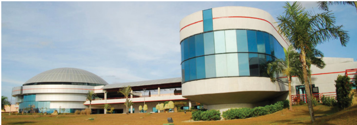
Vista frontal da sede administrativa do Parque onde estão também os auditórios, salas multiuso e restaurante. À direita, obras do Centro Empresarial II, previsto para ser inaugurado em
