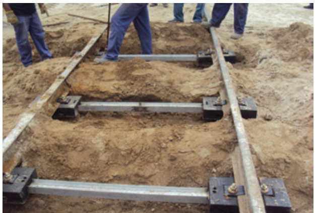
Uma das inovações anunciadas por empresa do parque: dormentes de borracha reciclada, derivada de pneus velhos. Criação da Metal Américas (instalada no Centro Empresarial) em parceria com a Vale, DuPont do Brasil e Instituto Fraunhofer, da Alemanha, o dormente dá função ao lixo que levaria mais de 600 anos para se decompor.
