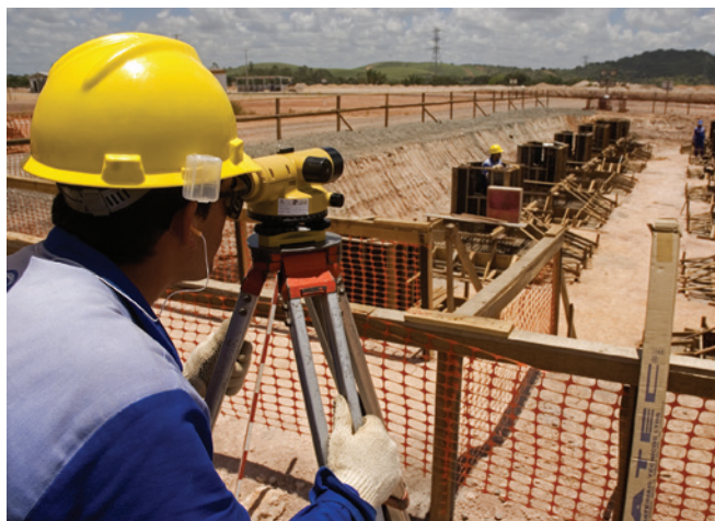
Obras da Refinaria Abreu e Lima, no Complexo Industrial Portuário de Suape: uma parceria da Petrobras com a estatal venezuelana de petróleo PDVSA
