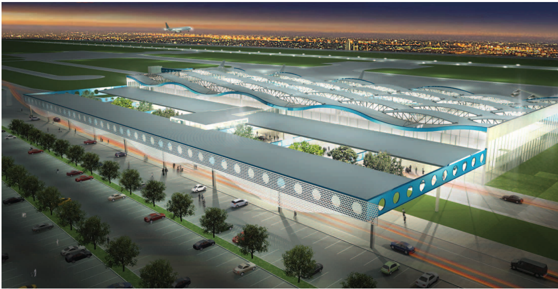
Projeto do Aeroporto Internacional de Cargas e Passageiros São Gonçalo do Amarante, distante 40 km de Natal, entrará em funcionamento em junho de 2014
