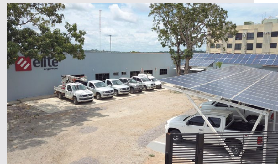
PLACAS SOLARES INSTALADAS NA SEDE DA ELITE ENGENHARIA
