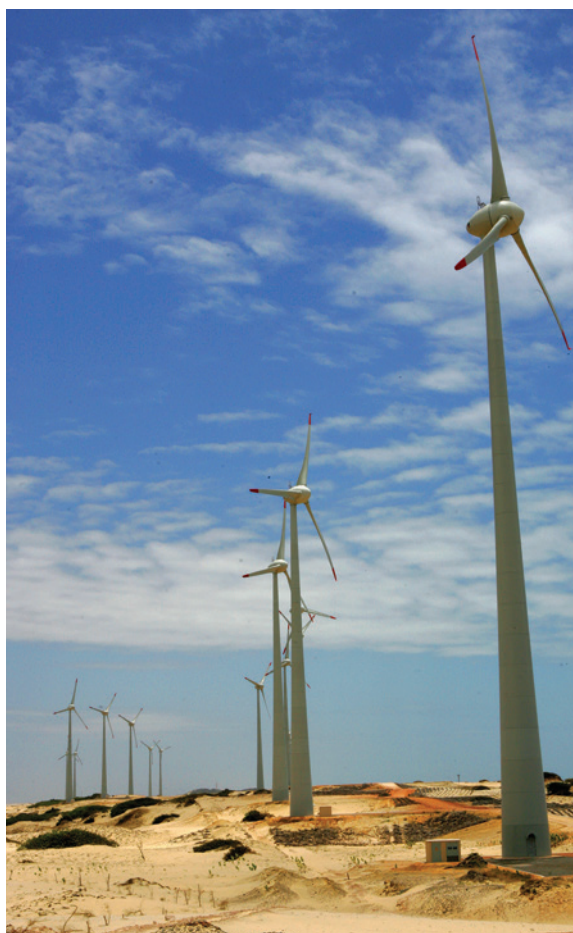
Usina de Energia Eólica de Beberibe, no Ceará: capacidade instalada de 25,6 MW e operações iniciadas em setembro de 2008
